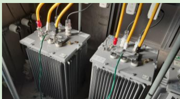
某病院改修工事 変圧器取替工事
