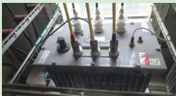
某中学校 変圧器取替工事
