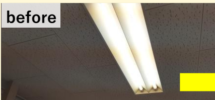
某診療所 LED化工事
